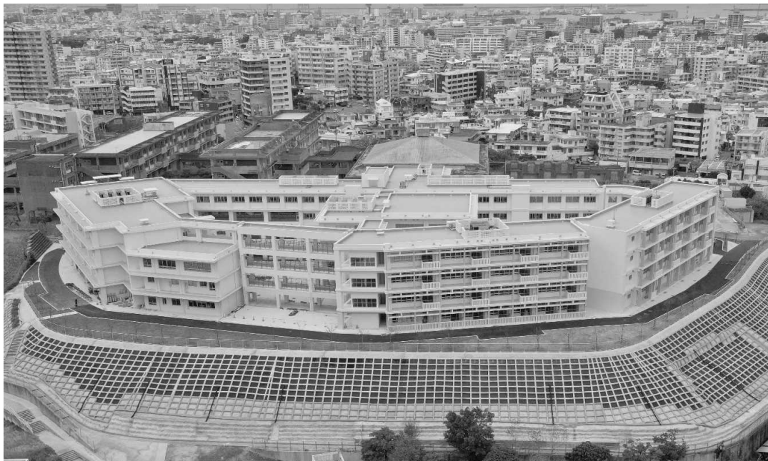
陽明高校校舎改築工事（浦添市）
