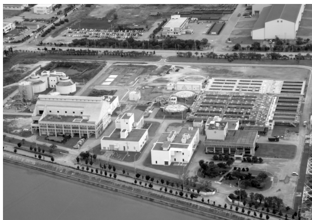
具志川浄化センター(みずクリン具志川)
