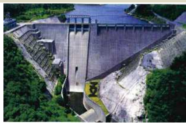
施工例(イメージ図) 中庸熱ポルトランドセメント
