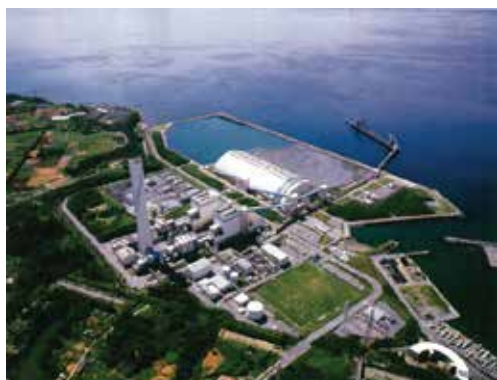
■ 沖縄電力(株)金武火力発電所(金武地区)
