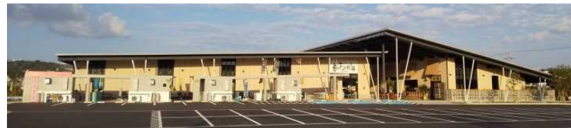
農水産物流通・加工・観光拠点施設（西原さわふじマルシェ）
