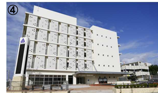
豊見城市役所新庁舎平成30年12月落成
