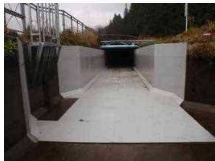
<用水路の補修（表面被覆工法）>
