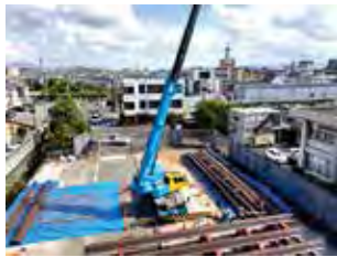
▲【工事中】地下貯留施設(大和高田市)
