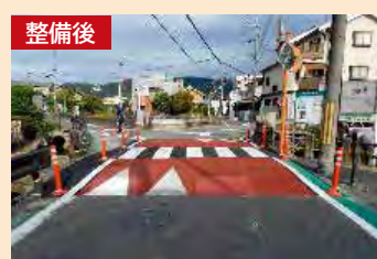
▲スムーズ横断歩道の整備
