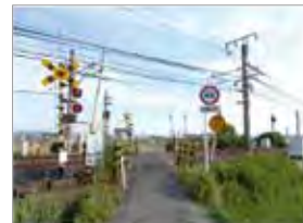
▲中八条踏切道
