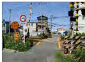
▲南大安寺踏切道
