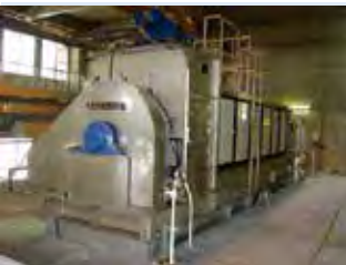
汚泥脱水機更新工事 (老朽化した機器の更新)
