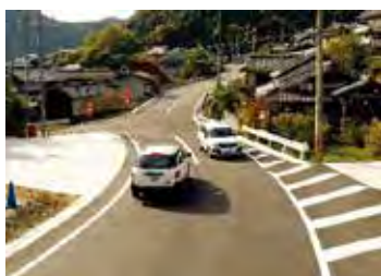
▲ アクセス道路の整備 (県道入野河原屋線(R5.9供用))
