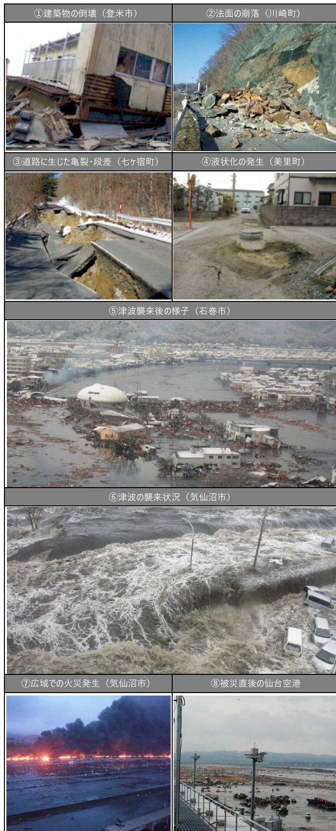
図-1.3 被災状況写真
