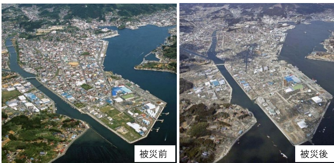
図-1.13 被災前後の状況写真（気仙沼市）
