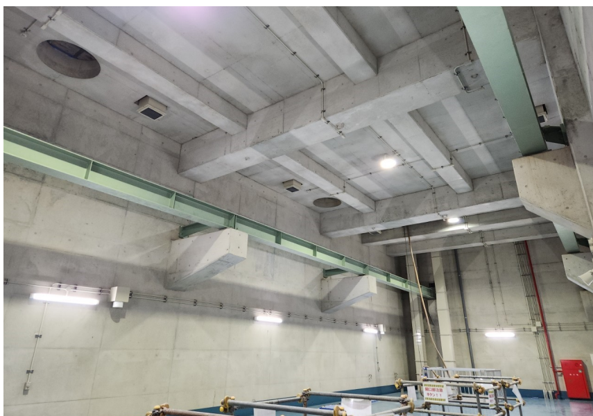
↑ ポンプ電動機室
