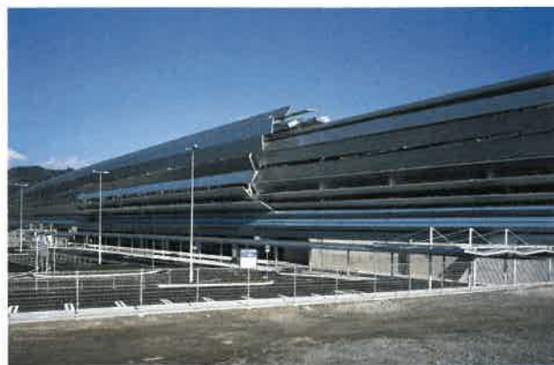
撮影／(株)アイオイ・プロフォート 九州新幹線新水俣駅
