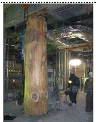
③出発ロビー設置中（長さ3.8m） 上端 直径 7.8cm 下端 直径 9.8cm
