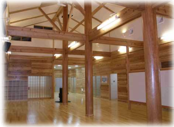
展示交流ホール (在来軸組工法と大断面集成材の架構)
