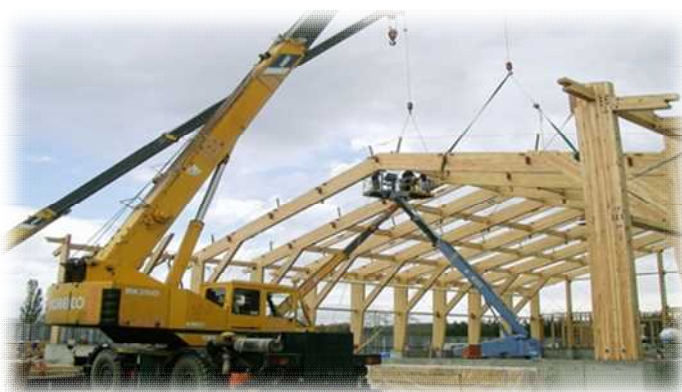
梁の組み立て
