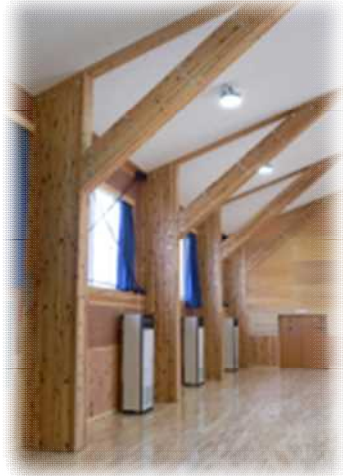
大断面集成材（柱、梁、方杖）
