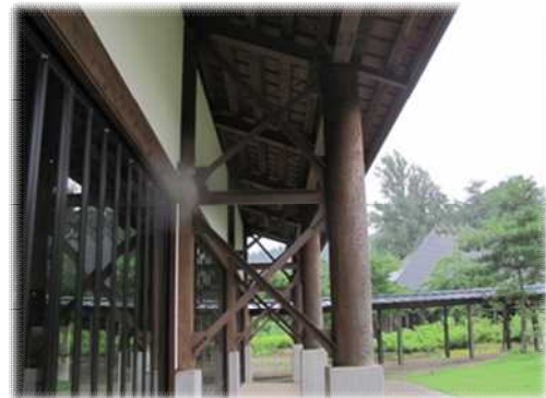
解放感のあるサッシと円筒LVL（木造風柱）
