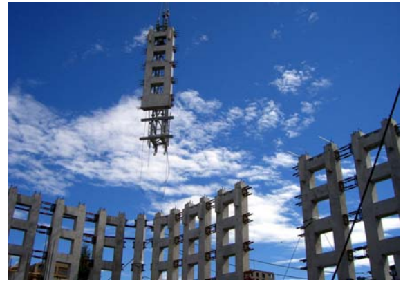
■柱梁部材架設状況
