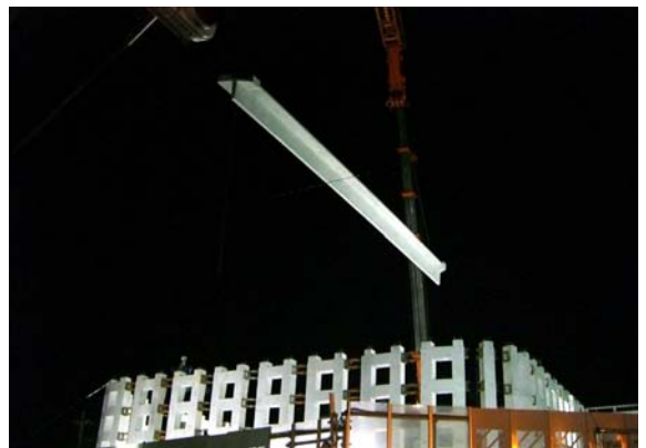
■PC 床版架設状況
