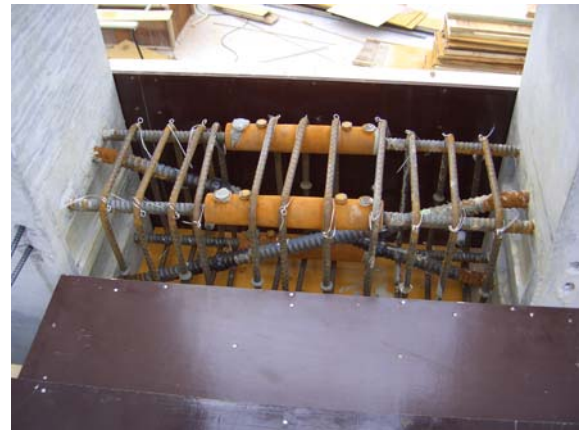
■梁主筋接続状況
