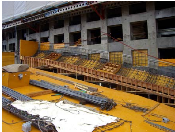
■スカート部施工状況
