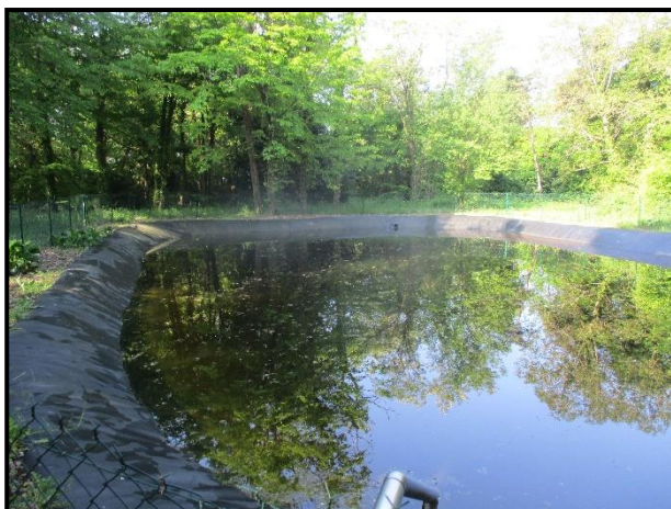
Photo 12 : Bassin de réserve incendie (Rainette ; 2019)
