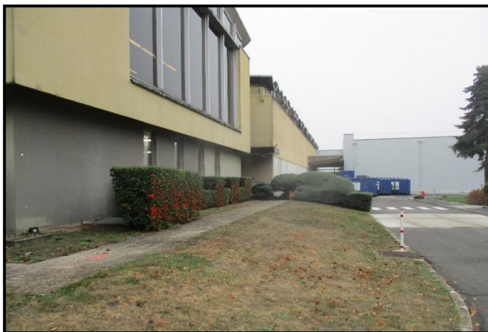
Photo 31 : Façade où la principale colonie de pipistrelles s'est installée (Rainette, 2018)
