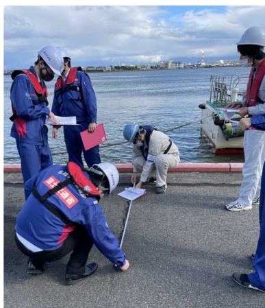
目視点検状況
