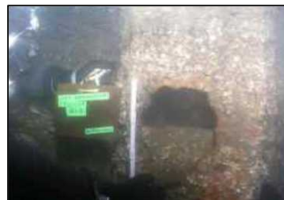
岸壁背後(土留工)の開孔
