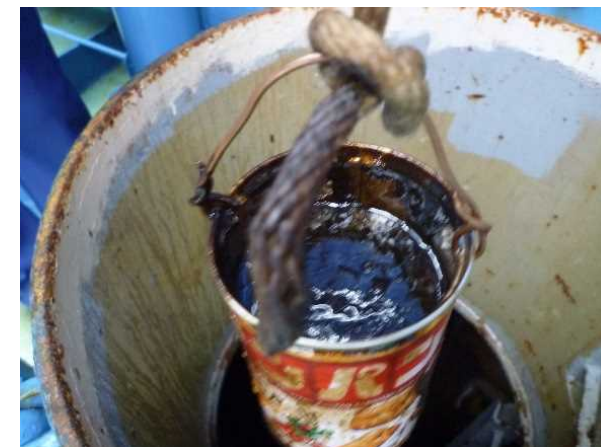
油水槽内の油確認
