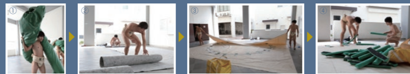
① 倉庫からマットを取り出し ▶ ② コンクリートの上に敷く ▶ ③ カバーを被せ ▶ ④ 俵替わりのスポンジを並べ完成
