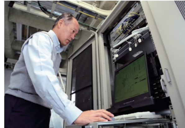
(写真上/左) フェーズドアレイレーダのコントロールユニット。レーダが捉えた降水分布観測の様子とモニター画面 (写真右) ドームの中に収められたフェーズドアレイレーダ。世界最速のスキャンニングが可能なレーダでゲリラ豪雨や竜巻の観測が可能。また世界にこの1台しかない
