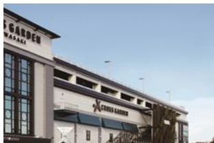
クロスガーデン川崎 (太陽光パネル)
