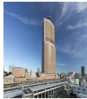
浜松アクトタワー
