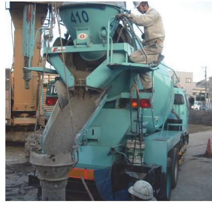
写真-3 場所打ち杭打設状況（適用例Ⅰ）
