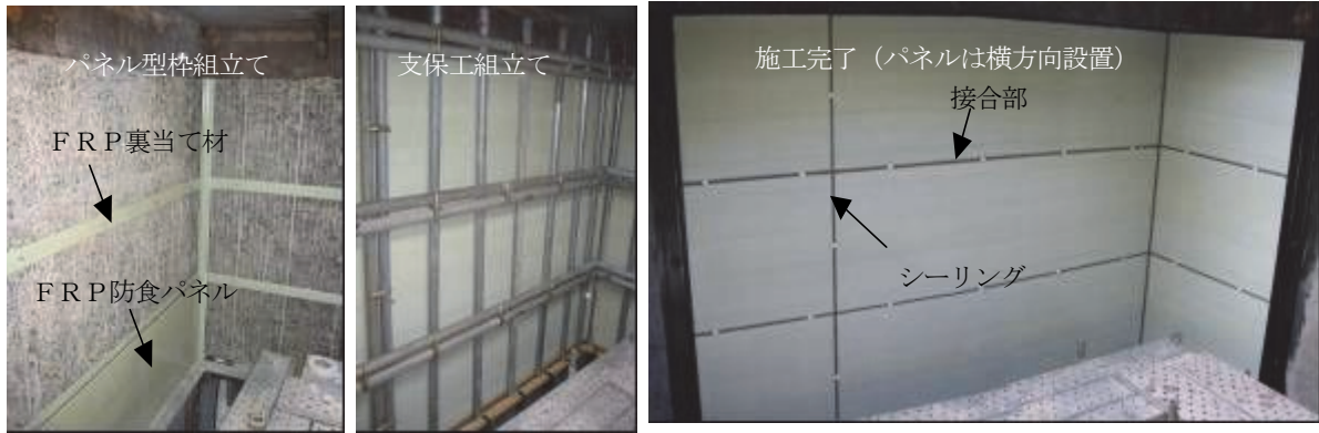
写真-7 試験施工状況
