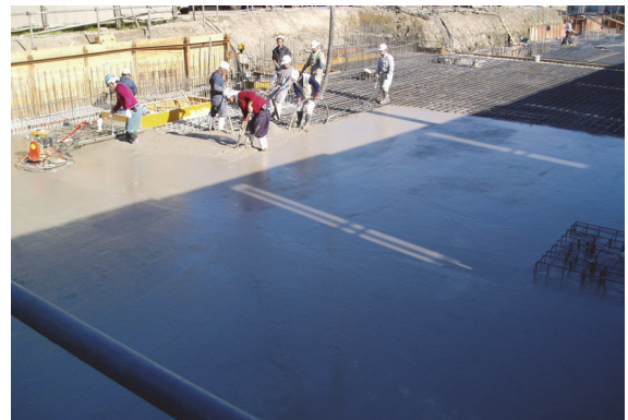
写真-4 耐圧盤打設状況（適用例Ⅰ）
