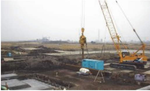
写真-1 鋼矢板打設工事周辺の概況
