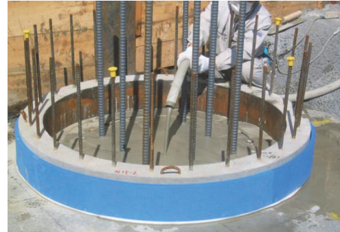
写真-2 杭頭接合部の施工状況
