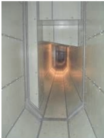
写真-8 箱抜き・段差部
