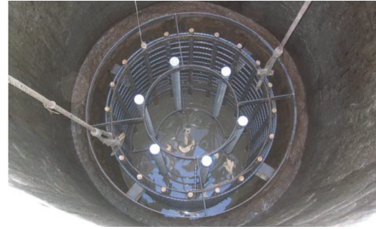
写真-1 杭鉄筋の建て込み状況
