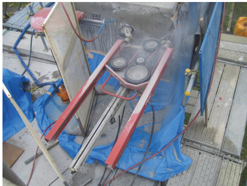
写真-2 ワイヤソー（水冷）
