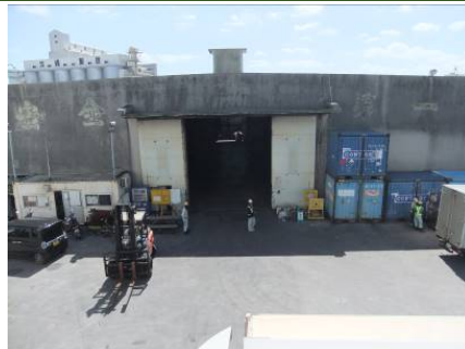
C 解体・移転予定の共同倉庫
