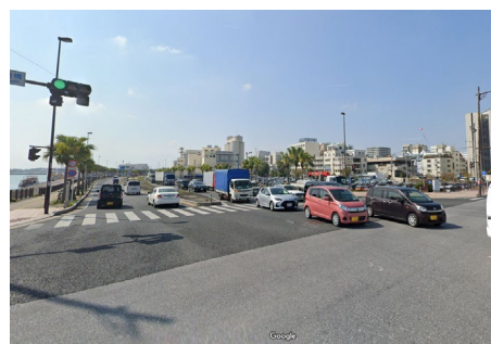
G 明治橋駐車場前交差点
