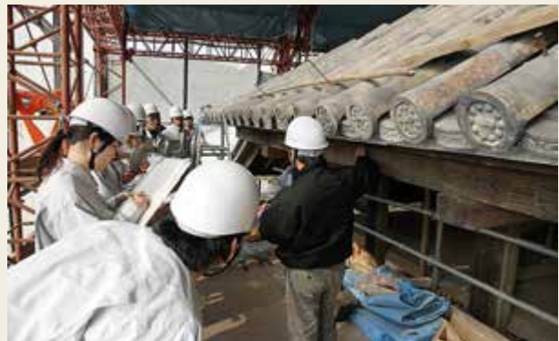
写真4 四日市別院修理工事の見学の様子（2015（平成27）年度）
