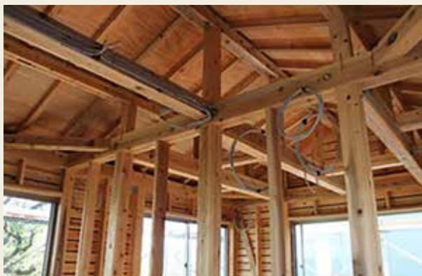
写真3 屋内配線実習（2階の配線）
