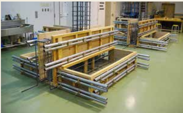
写真2 RC造柱脚部分の組み立て（建築施工実習）
