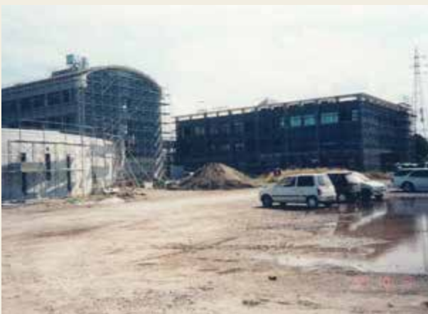
建設が進む管理棟、研究棟及びアネックス（1997（平成9）年10月）
