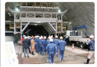
現場見学（全学年） （下屋形トンネル）
