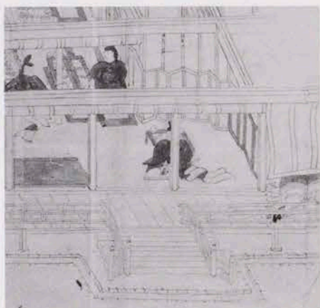
賣子縁、庇の間、母屋（寝殿中央部）
