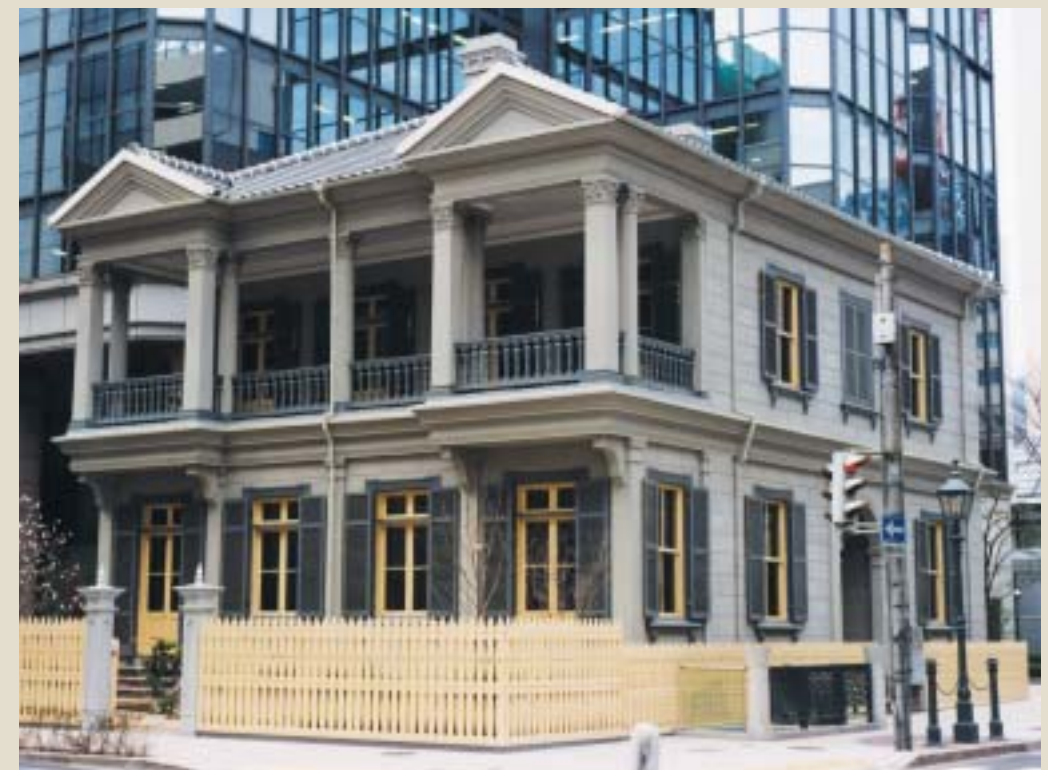
重要文化財に指定され、復旧工事後の十五番館
