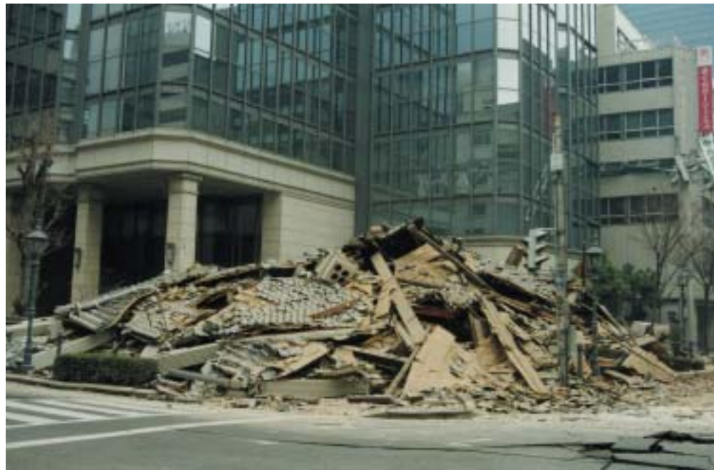
震災で全壊した十五番館
