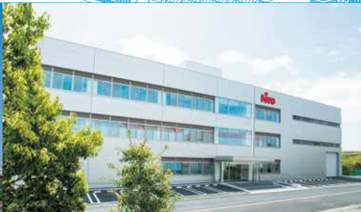
■菊川ラボラトリ 風雨・耐震試験棟
