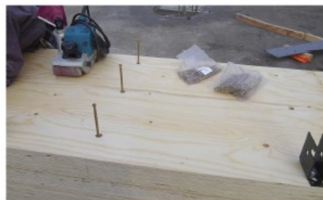
間隔的に内蔵型スクリーブビスで“二次接着”
