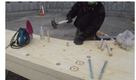
方杖と柱・梁連結に貫通まで木製ピンを打ち込み
