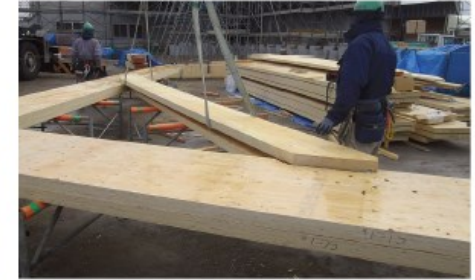
2枚目の方杖を上から柱・梁に載せ
