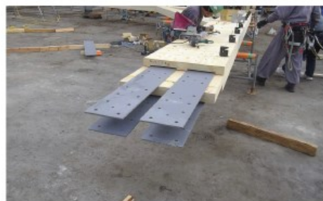
金具の取付け(縦り、横梁や合板受け材など用)
