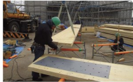
梁を上から柱に載せ
