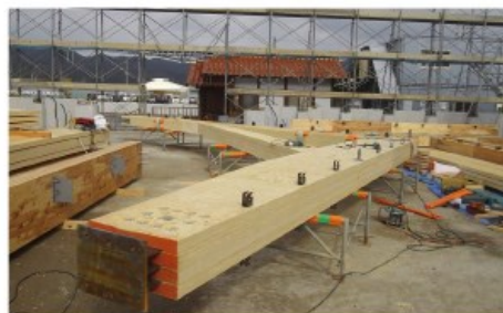
同じように4枚合せの柱・梁・方杖組立
