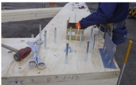
柱と梁連結に貫通まで金属製ピンを打ち込み
