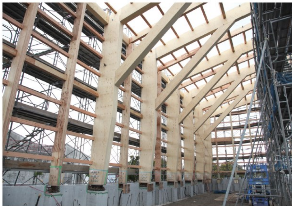
同じように4枚合せの柱・梁・方杖組立
