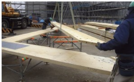
方杖を上から柱・梁に載せ
