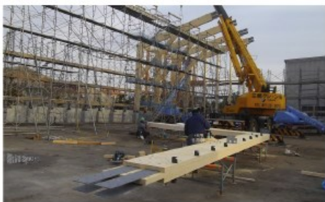
75mmLVL × 3枚合せの柱・梁・方杖組立完成
