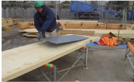
柱・梁連結に鉄板敷き
