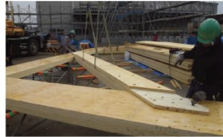
3枚目の方杖を上から柱・梁に載せ
