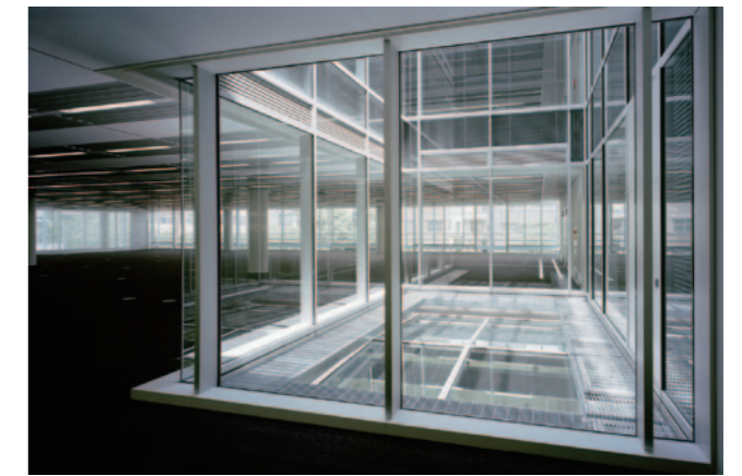
自然換気を設けた光庭
