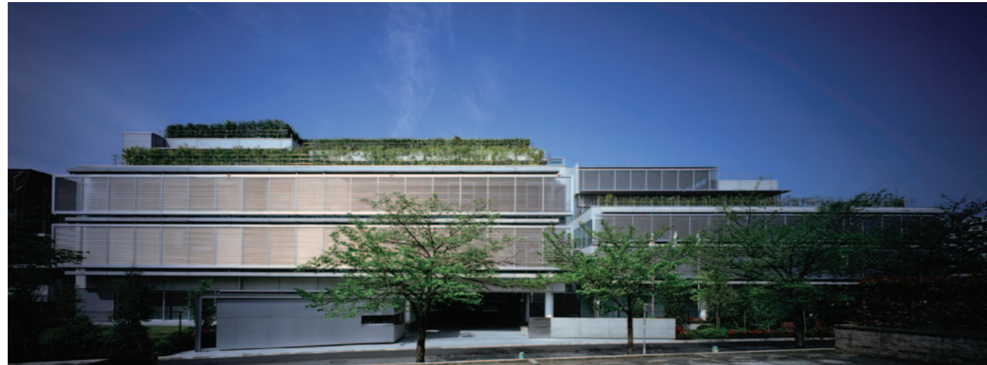
外部可動ルーバーと屋上緑化
