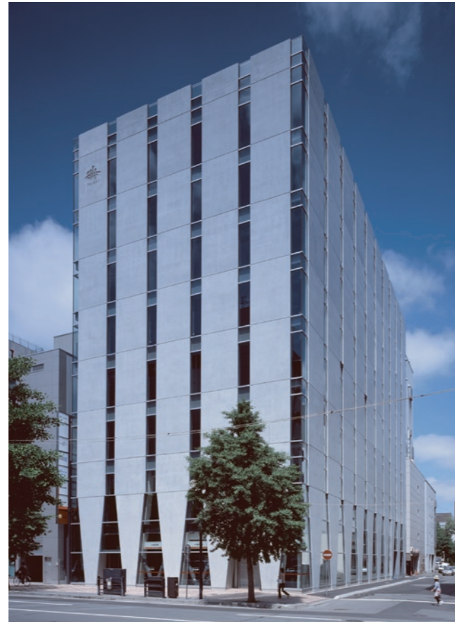
構造架構を現した外観
