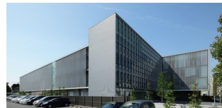
視線と光を制御する外壁ルーバー
