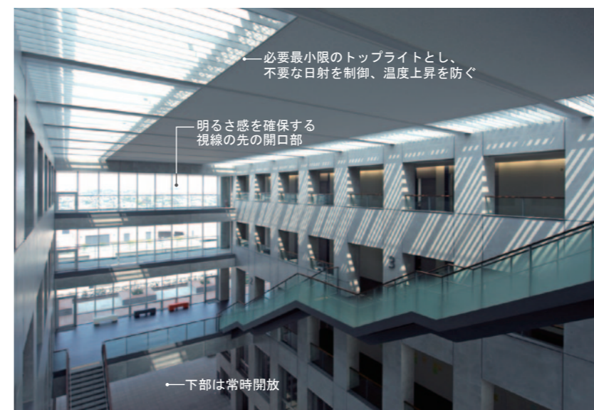
半屋外型アトリウム
