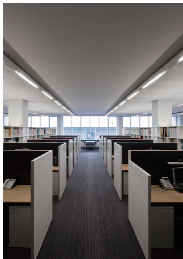
直天井のオフィス：階高3.5mで天井高さ3mの空間を実現
