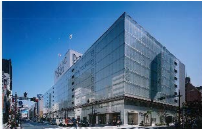
改修後建物外観
