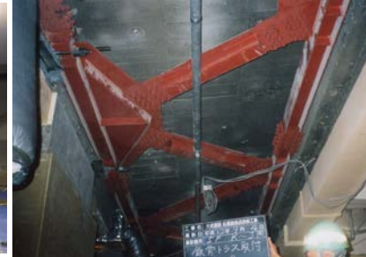
水平トラス補強
