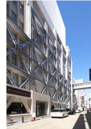
外付けブレース補強
