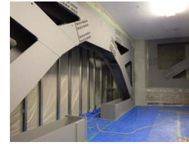
鉄骨ブレース設置状況
