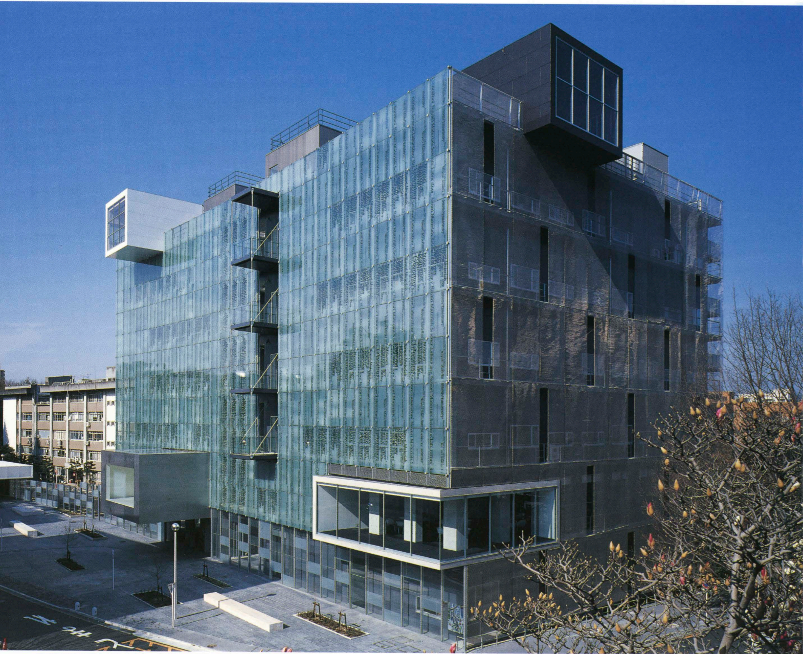
物質科学研究館を北東側より見る View of the Materials Science Laboratory from the northeast.
