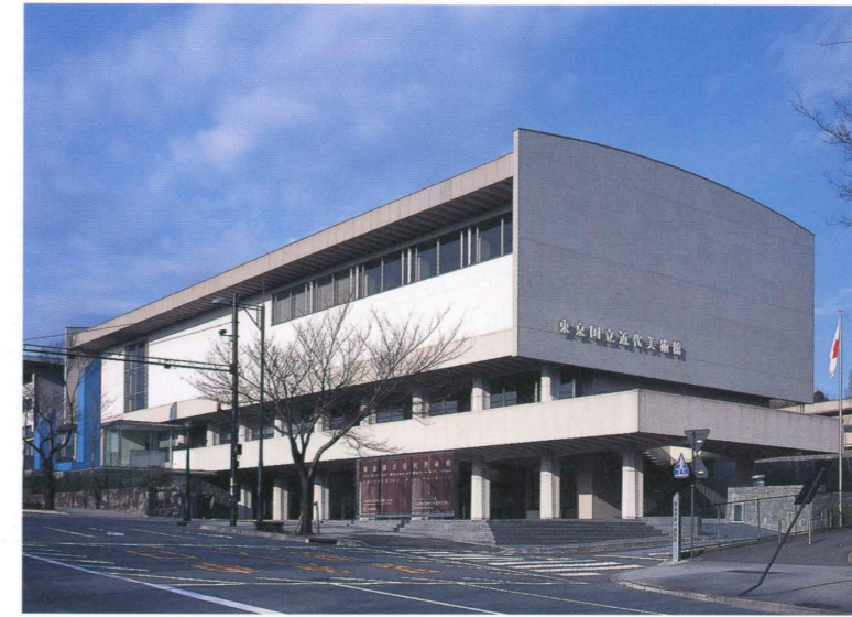
南東側から見る View from the southeast.
