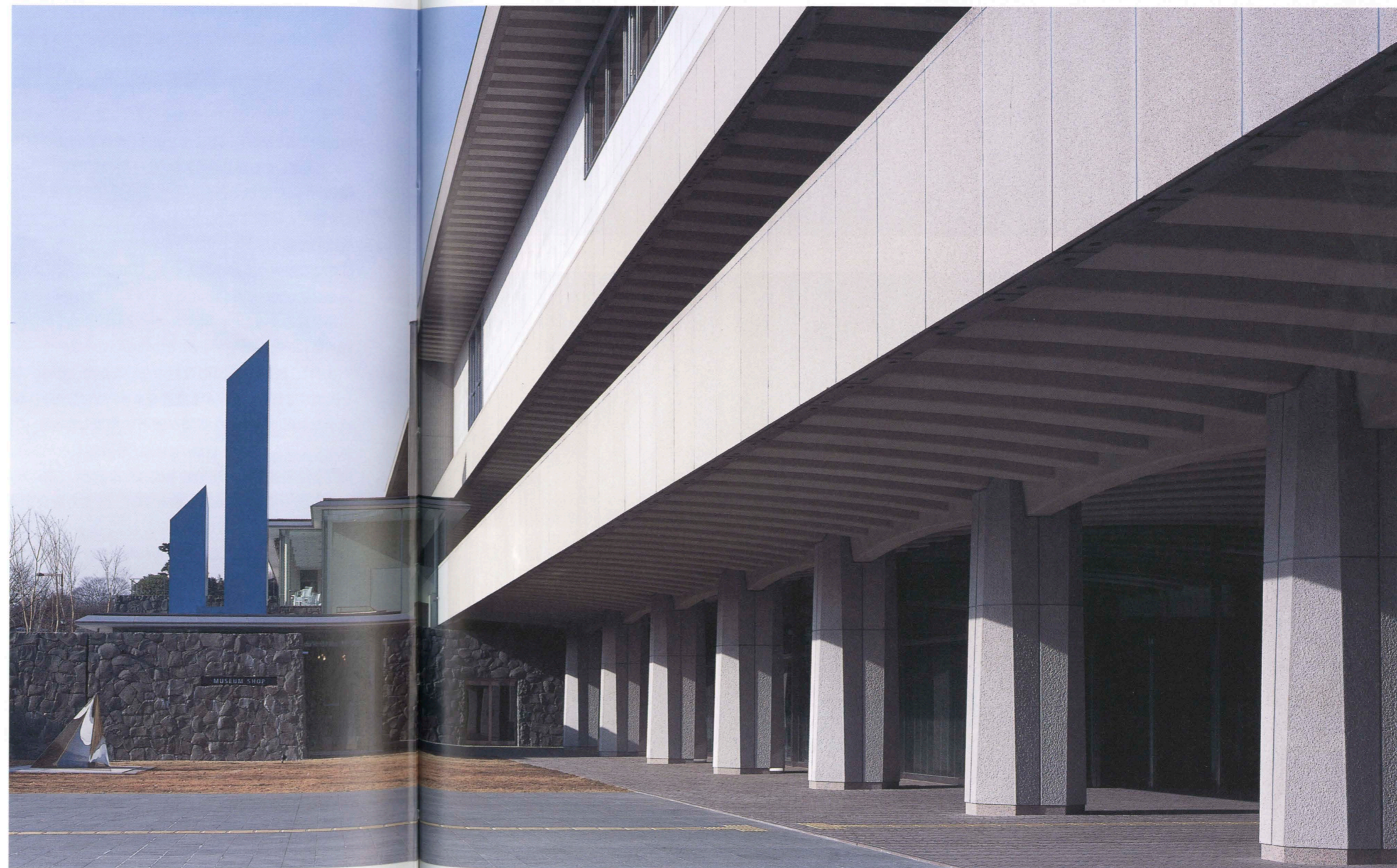
エントランス前より見る View from the front of entrance.
