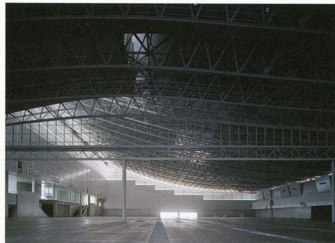
間仕切りを外した状態の展示ホール Exhibition hall without the partitions.
