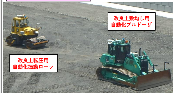
▲ 改良土敷均し・転圧
