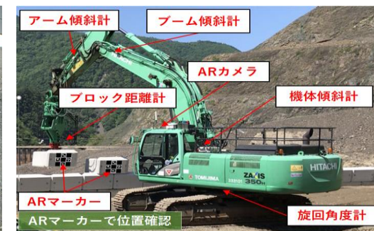
▲ コンクリートブロック設置
