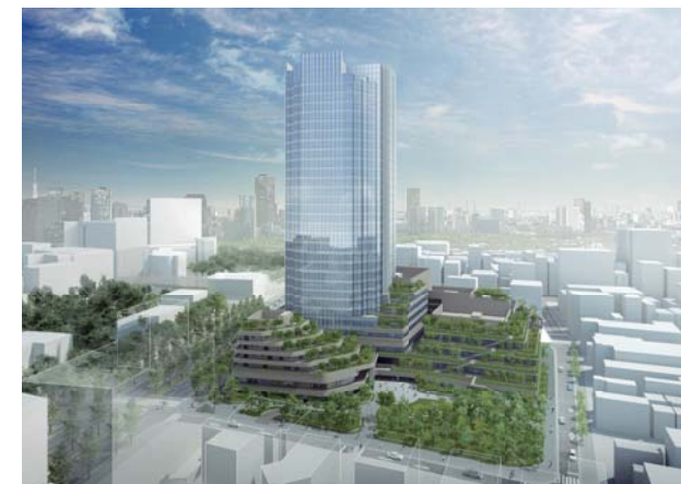
四谷駅前地区 東京都新宿区 2019(予定) 地上31階、地下3階 事務所、住宅、店舗、教育施設、公益施設、駐車場等 区域面積：2.4ha 敷地面積：17,900㎡ 延床面積：139,600㎡ 容積率：670% 計画手法：再開発等促進区 事業手法：第一種市街地再開発事業
