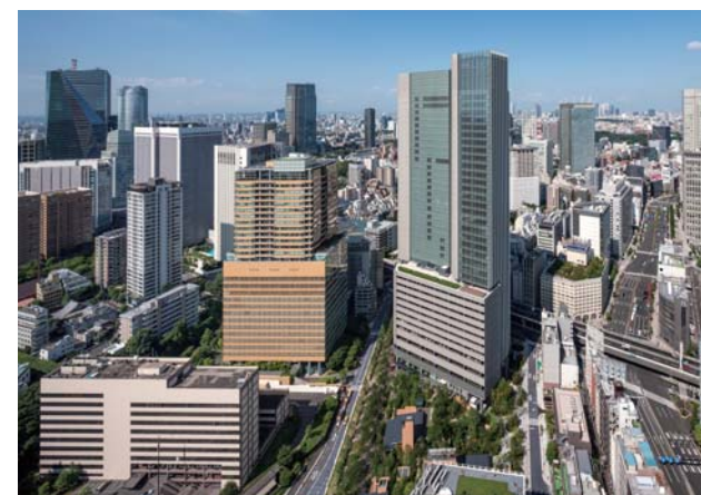
赤坂インターシティ AIR／赤坂一丁目地区 東京都港区 2017 地上38階、地下3階 事務所、住宅、店舗、カンファレンス、医療施設、駐車場等 区域面積：1.6ha 敷地面積：16,090㎡ 延床面積：178,330㎡ 容積率：900% 計画手法：再開発等促進区 事業手法：第一種市街地再開発事業 権利者数：247名（借家人含む）
