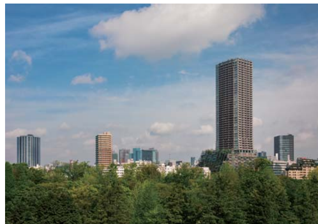
としまエココミュニゼタウン／南池袋二丁目A地区 東京都豊島区 2015 地上49階、地下3階 住宅、庁舎、店舗、事務所、駐車場等 区域面積：1.1ha 敷地面積：8,330㎡ 延床面積：94,680㎡ 容積率：800% 計画手法：再開発等促進区、街並み再生地区 事業手法：第一種市街地再開発事業
