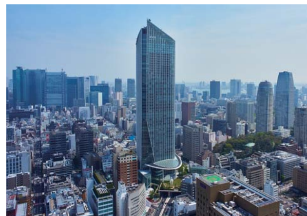
虎ノ門ヒルズ／環状二号線新橋・虎ノ門地区III街区 東京都港区 2014 地上52階、地下5階 事務所、住宅、店舗、文化・交流施設、駐車場等 区域面積：5.7ha 敷地面積：17,070㎡ 延床面積：244,360㎡ 容積率：1,150% 計画手法：再開発等促進区、都市施設の立体都市計画（III街区内の都市計画道路） 事業手法：第二種市街地再開発事業
