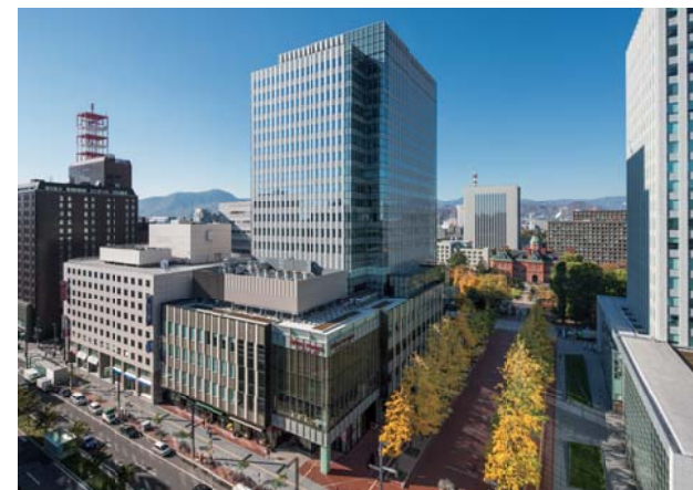
札幌三井JPビルディング 札幌市北3条広場／北2西4地区 北海道札幌市 2014 地上20階、地下3階 事務所、店舗等 区域面積：1.5ha(都市再生特別地区の区域) 敷地面積：5,520㎡ 延床面積：68,190㎡ 容積率：1,270%(都市再生特別地区全体の容積率最高限度) 計画手法：都市再生特別地区 事業手法：都市再生事業
