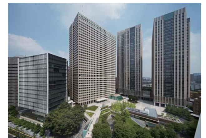
霞が関ビルディング・東京倶楽部ビルディング／霞が関三丁目南地区B地区 東京都千代田区 2009 地上37階、地下4階（霞が関ビルディング）/ 地上14階、地下1階（東京倶楽部ビルディング） 事務所、店舗、駐車場等 区域面積：1.9ha 敷地面積：16,300㎡ 延床面積：155,270㎡ 容積率：950% 計画手法：再開発等促進区
