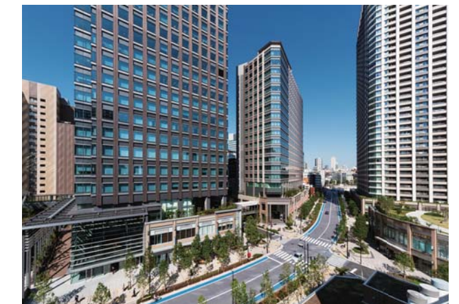
パークシティ大崎／北品川五丁目第1地区 東京都品川区 2015 (全体竣工) 地上31階、地下2階 (超高層業務棟) / 地上18階 (高層住宅棟) / 地上2階 (地域交流施設棟) 地上20階、地下2階 (高層業務棟) / 地上4階 (作業所棟) 地上40階、地下2階 (超高層住宅棟) / 地上2階 (店舗) 事務所、住宅、店舗、子育て支援施設、工場、地域コミュニティ施設、産業支援交流施設、駐車場等 区域面積: 3.6ha 敷地面積: 28,380㎡ (全体) 延床面積: 250,160㎡ (全体) 容積率: 708% (平均) 計画手法: 都市再生特別地区 事業手法: 第一種市街地再開発事業
