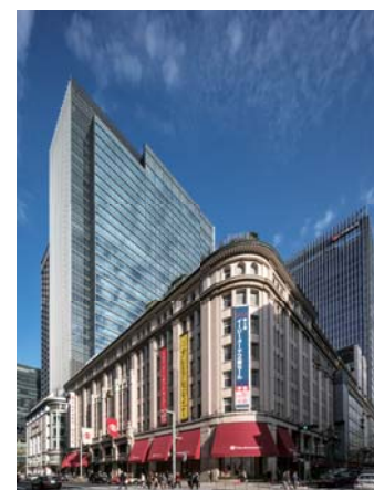
太陽生命日本橋ビル、日本橋高島屋、日本橋高島屋三井ビルディング/ 日本橋二丁目地区 東京都中央区 2019 地上 27 階、地下 5 階 (A 街区) / 地上 8 階、地下 3 階 (B 街区) / 地上 32 階、地下 5 階 (C 街区) / 地上 1 階、地下 1 階 (D 街区) 事務所、店舗、エネルギーセンター、駐車場等 区域面積：2.6ha 敷地面積：17,640 m 2 延床面積：282,000 m 2 容積率：1,400% 計画手法：都市再生特別地区、地区計画 事業手法：第一種市街地再開発事業
