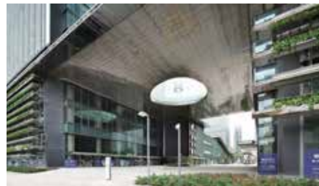
大庇の下のオフィス入口広場 | Semi-Open Entrance Space to Office under Great Eave
