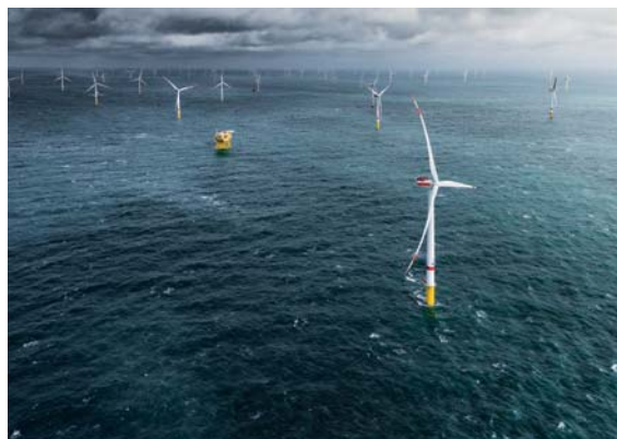
（写真提供：MHI Vestas Offshore Wind A/S）
