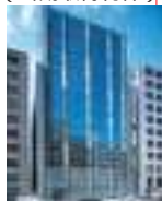
NBF広島立町ビル
