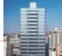
横浜STビル
