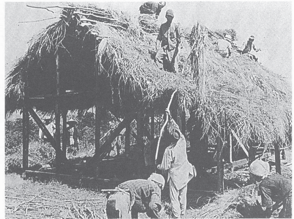
米軍支給の資材で規格住宅（キカクヤー）の建設
