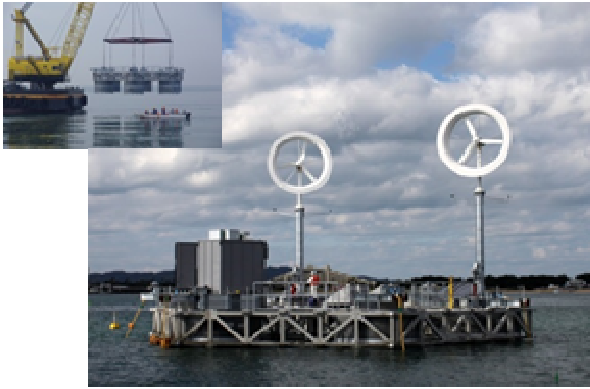
図 11 浮島式エネルギーファーム（博多湾プロジェクト、ステージ I）、18m 浮体、3kW レンズ風車 2 基、2kW 太陽光パネルの合計 8kW エネルギーステーション、2011.12.4.
