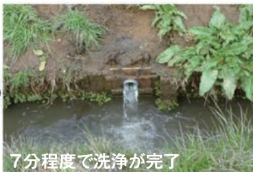
(写真6 幹線パイプの洗浄)
