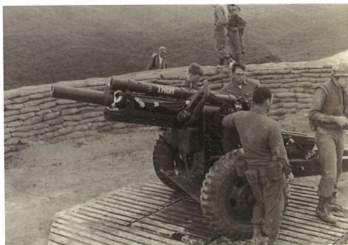
発射台には、すでに砲座4カ所、壕2カ所、弾薬庫3カ所、ヘリポート2カ所が完成、周辺およそ1.5haの基地は、有刺鉄線がはりめぐらされていた。(上原一夫提供)
