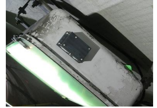
トンネル内照明 取付状況
