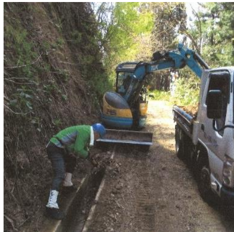
側溝の土砂除去作業
