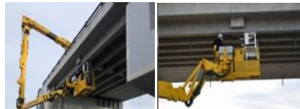
バケット式橋梁検査車を用いた測定例
