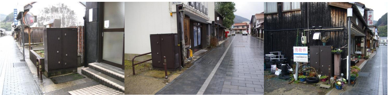
民地内に設置された路上機器
