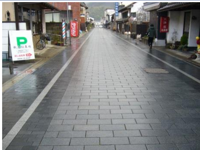
歩道舗装（全景）
