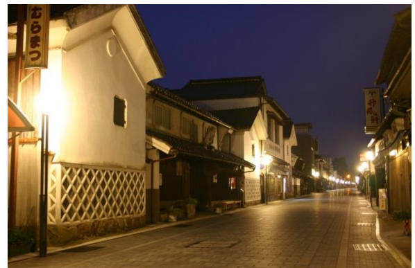
夜間照明状況
