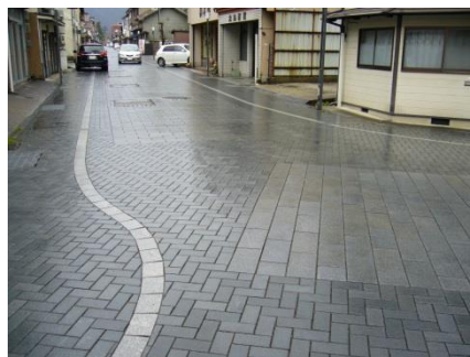
クランク部分の舗装納まり
