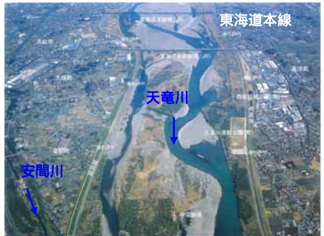
東海道線下流部付近の状況
