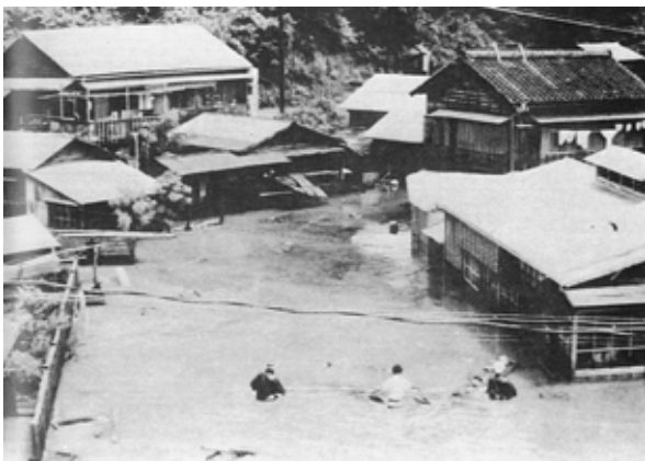
浜松市佐久間地区の浸水状況
