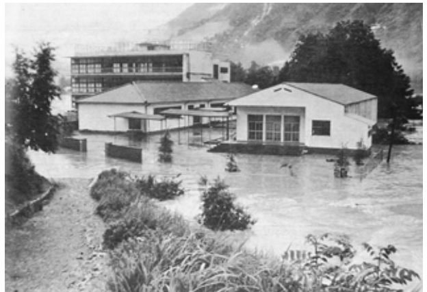
浜松市佐久間小学校の浸水状況
