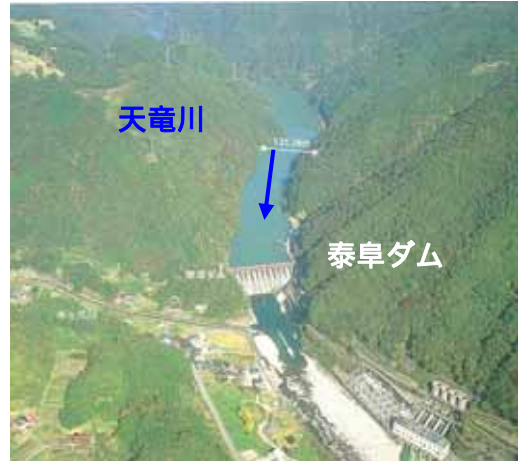
泰阜ダム付近の状況
