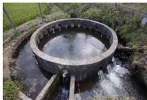
土木学会ホームページ 平成 18 年度の推奨土木遺産より
