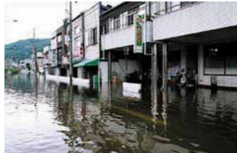
諏訪市内の浸水状況
