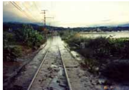
飯田市川路地区 (JR 飯田線浸水)
