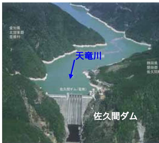
佐久間ダム付近の状況
