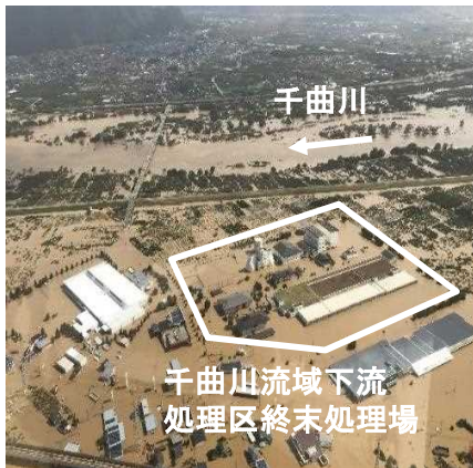
浸水した下水処理場 (長野県 千曲川下流処理区)
