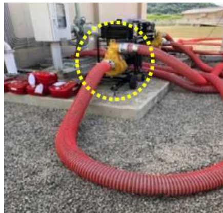
仮設ポンプ等の資機材の確保 (広島県倉敷市)
