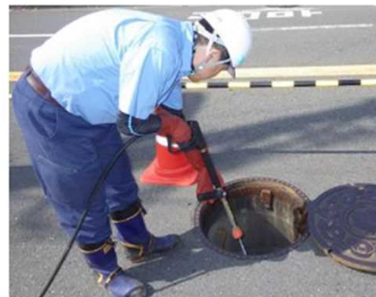
高圧水による洗浄状況
