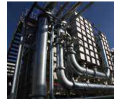
超高効率固液分離槽
