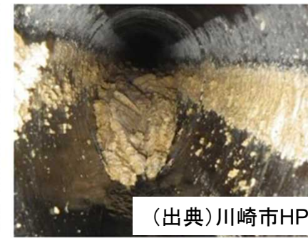
ロード(油)で閉塞した下水道管きよ
