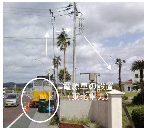
非常時の電源確保 (電源車による受電)
