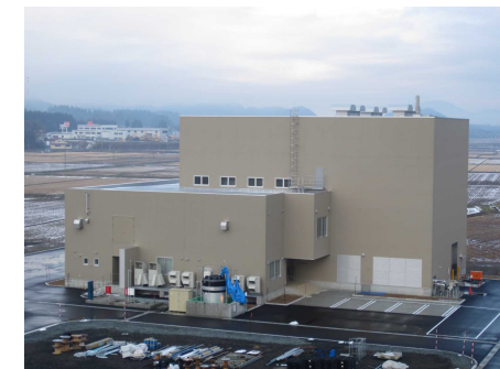
【汚泥資源化施設概要】 処理方式:炭化による資源化 処理能力:約7,800 ton/年
