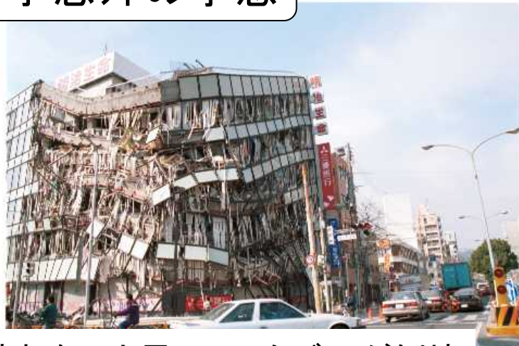
壊れないと思っていたビルが倒壊
