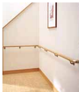
<手すりの設置>
