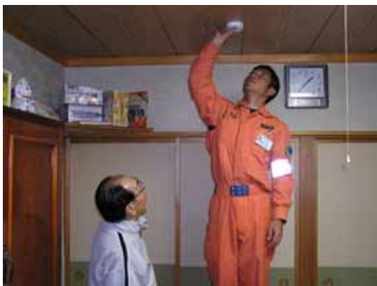
【火災警報器取り付けの様子】
